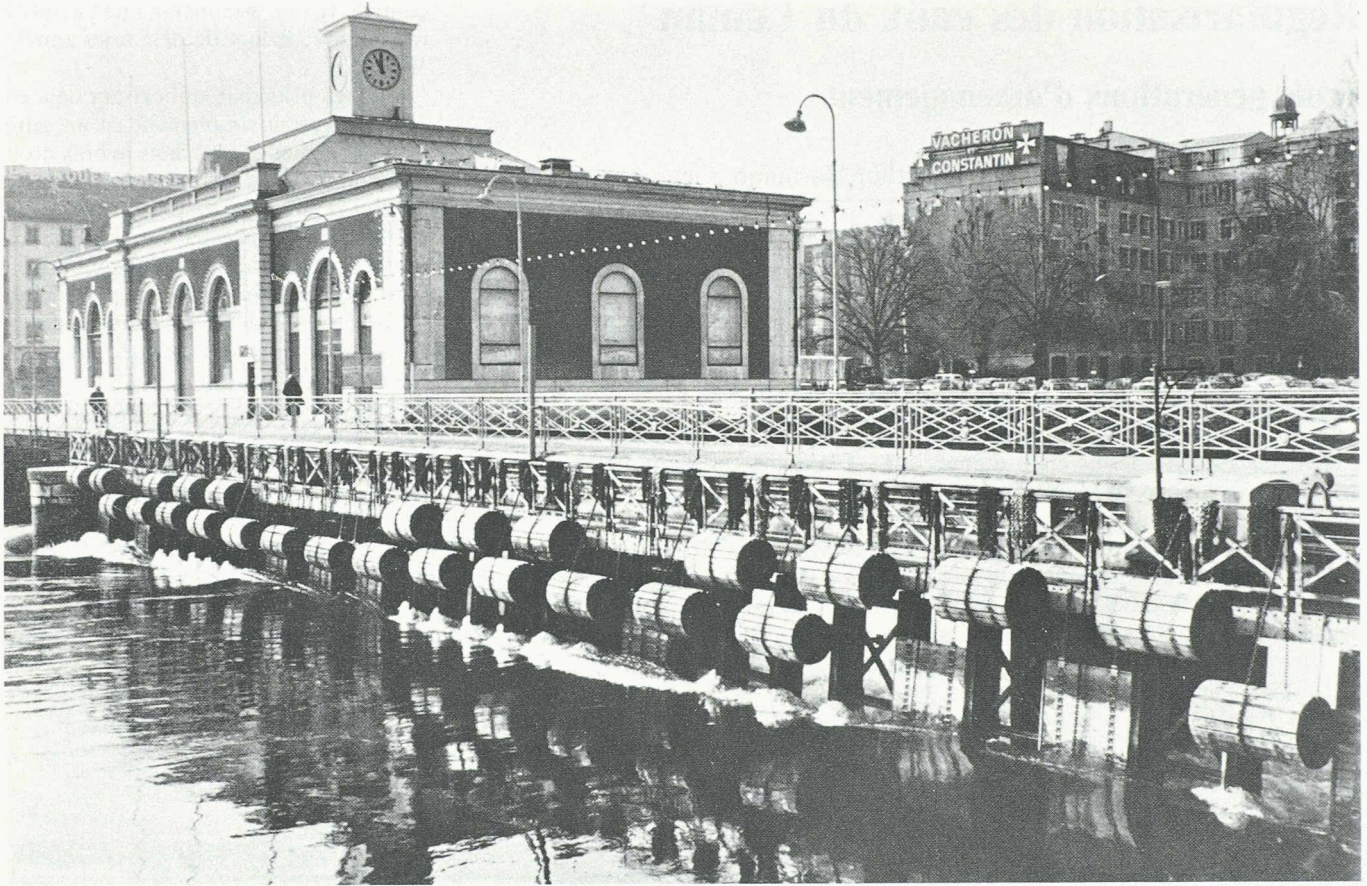
Fig. 3. — Le barrage système Caméré, au pont de la Machine. Vue d'amont.
