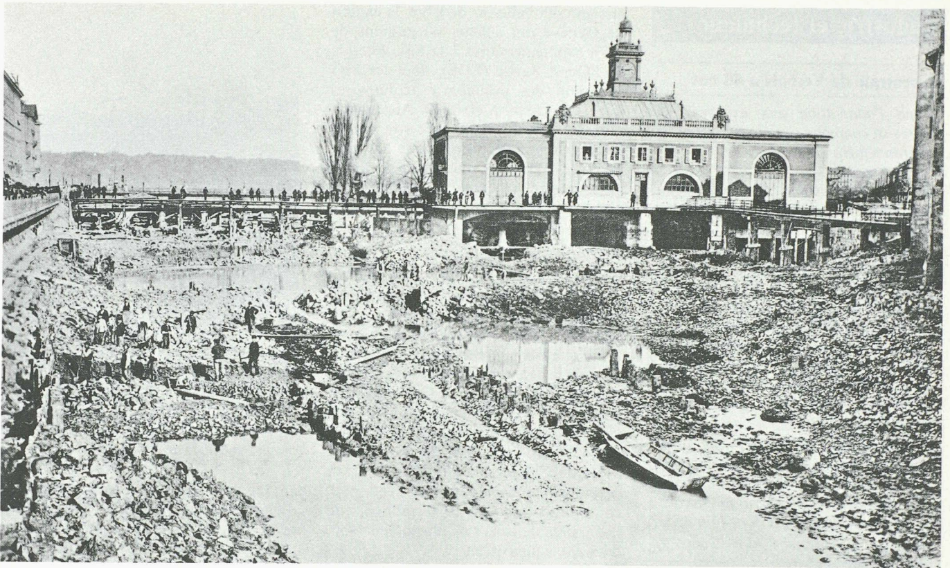
Fig. 10. — Travaux d'approfondissement dans le bras droit du Rhône. Mars 1887.
