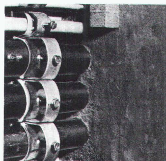
Séparation type VAM-W pour traversées de parois
