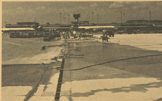
Fig. 5. — *Polydrains* posés dans du béton armé.
