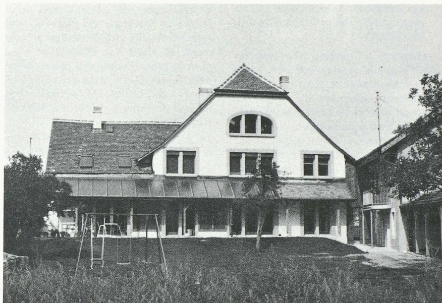
Fig. 3. — Vue de la façade sud, après transformation.
