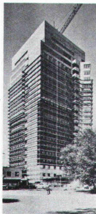
Revêtement de façade
