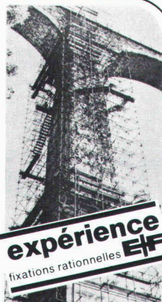
Fixation d'un coffrage
