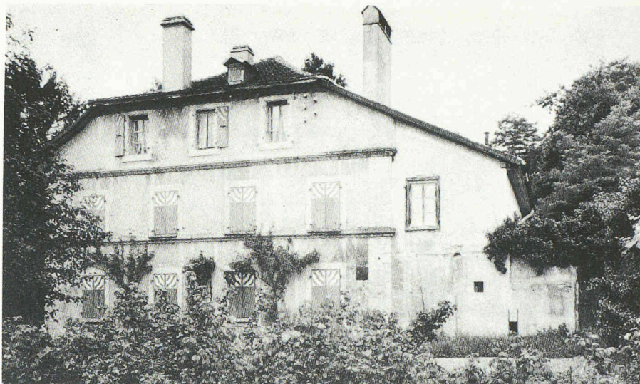
La cure de Prilly avant la restauration
