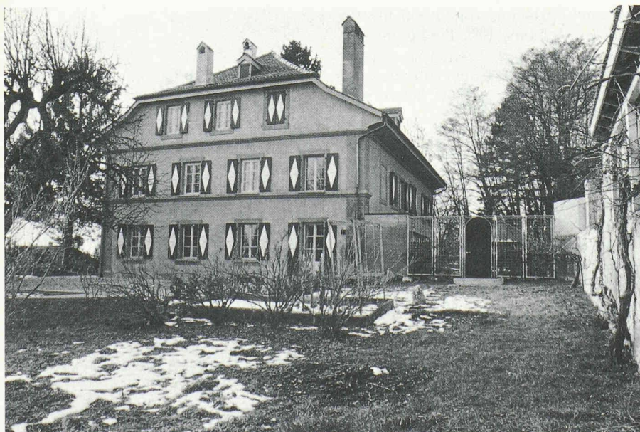
La démolition de l'ancienne annexe permet de rééquibrer la façade et de mettre en relation la cour et le jardin
