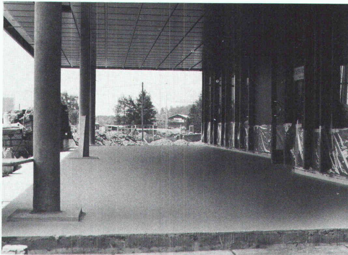
Halle d'entrée station d'épuration Revêtement étanche sous carrelage
