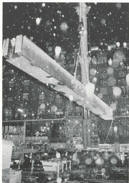
Fig. 5. — Montage de nuit d'un sommier caissonné.
