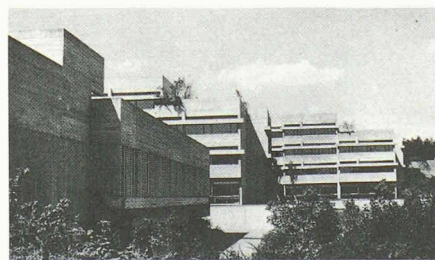
2422 Zollikofen 1962-66 Schulhausstrasse 30, Arch. Mäder und Brüggemann
