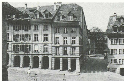
3145 Bern Altstadt 1963–64 Altstadtreparatur, Gerechtigkeitsgasse 12+14, Arch. Halmeyer Hans
