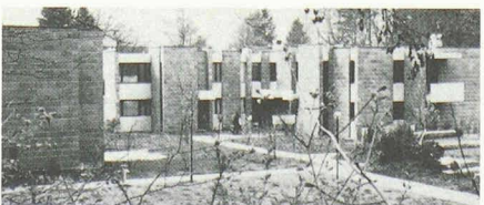
2304 Muri b. Bern 1976–80 EFH-Parksiedlung Villette, in verdichteter Bauweise, Arch.gem. Hostettler Hans, Stukky Ulrich
