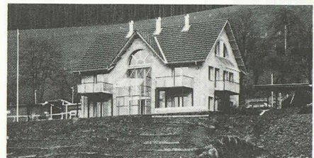
2312 Gümligen 1984 Einfamilienhaus Furrer, Arch. Althaus Jürg
