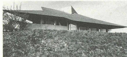
2030 Rüeggisberg 1970 Einfamilienhaus, Arch. Anderegg E.
