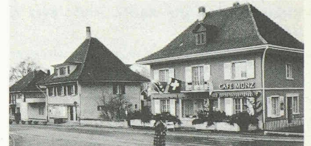
4091 Ins 1922–23 Einfamilienhäuser (Frühbauten) von Salvisberg O.R., Bahnhofstrasse 8/10
