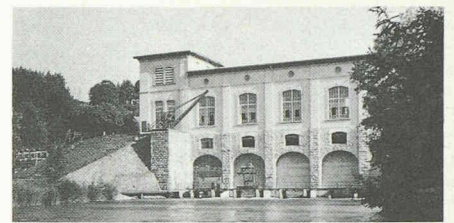
4081 Hagneck 1897–1900 BKW-Wasserkraftwerk, gutes Beispiel früher Industriearchitektur (wird später ausführlicher gezeigt)
