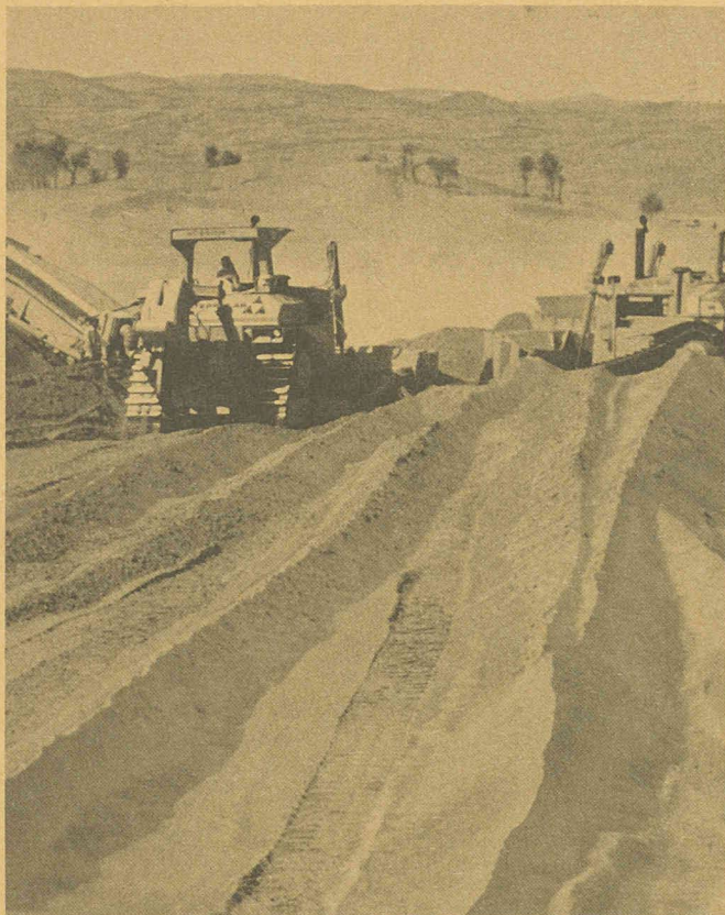
Pour la construction de l'aéroport de Al Ain à Abou Dhabi, qui exige le déplacement de 20 millions de m 3 de sable, la société CCC a notamment mis en service 54 machines Cat, dont une douzaine de tracteurs de la Série L. Ce D9L Cat, qui se reconnaît à son barbotin monté en position haute, développe une puissance nominale de 343 kW (460 HP).
