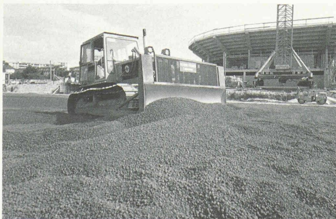
Fig. 11. — Mise en place du LECA.
