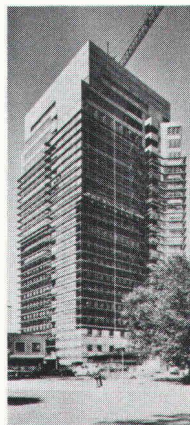
Revêtement de façade
