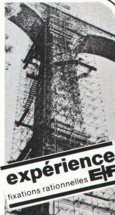
Fixation d'un coffrage
