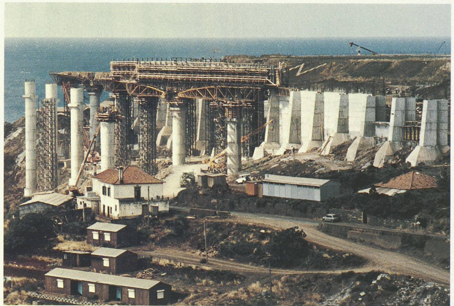
Fig. 20. — Le chantier de la piste 24 photographié le 9 juillet 1984.
