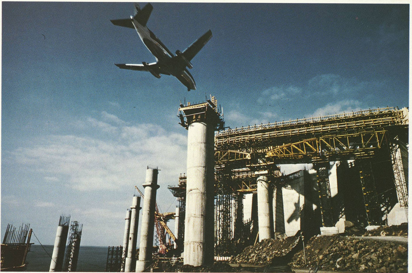
Pas d'interruption du trafic aérien pendant les travaux: approche vers le seuil de piste 24 (en haut) et vers le seuil 06 (en bas).
