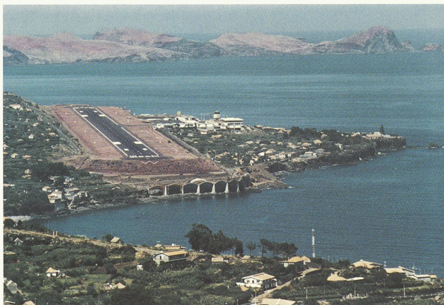
Fig. 1. — Vue générale de l'aéroport de Funchal. On distingue les travaux de prolongement de l'extrémité 06 de la piste, avec les voûtes servant de soutènement au remblai et de protection de ce dernier contre l'érosion marine. A droite, l'aérogare et l'aire de stationnement faisant également l'objet d'une extension.
