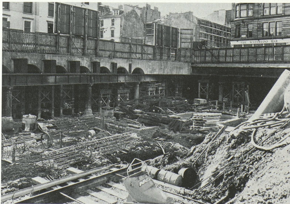
La zone des quais inférieurs de la gare centrale de Glasgow en cours de préparation pour les travaux de construction pendant lesquels les piliers existants supportant Argyle Street ont été temporairement complétés de tréteaux en acier.
