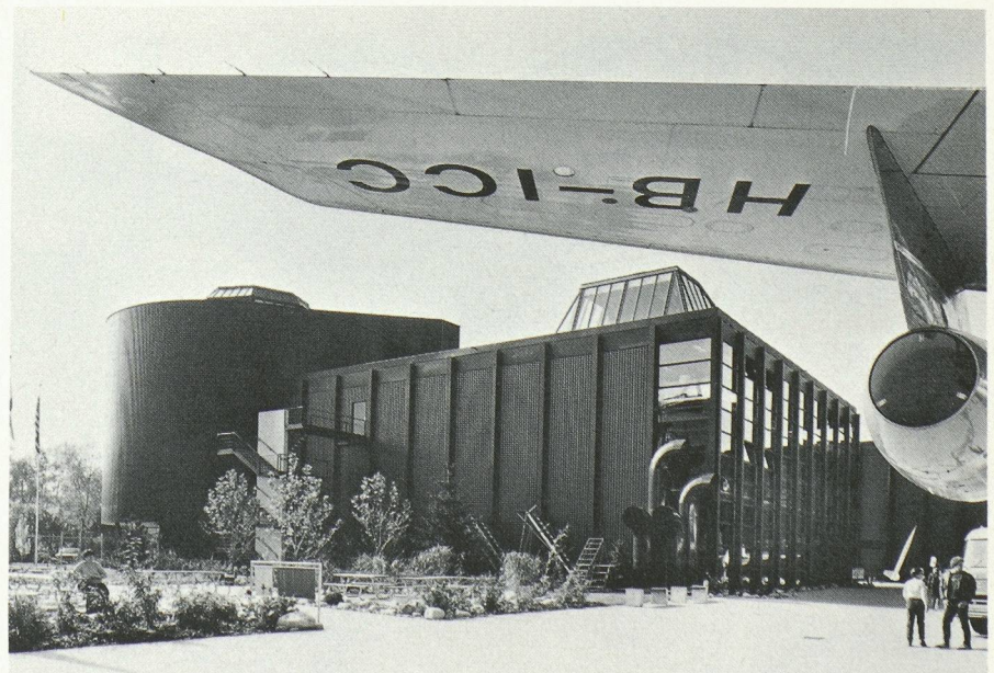
Liberté du parti architectural, audace dans la juxtaposition des volumes: la nouvelle halle du Musée des transports de Lucerne. (Photographies: B.+M. Dermond, Zurich, et Geilinger SA.)
