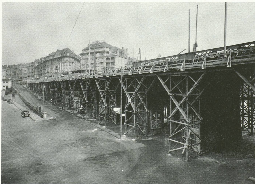
Rien de nouveau à l'utilisation du bois dans le génie civil : travaux de coffrage lors de l'élargissement du Grand-Pont, à Lausanne.
