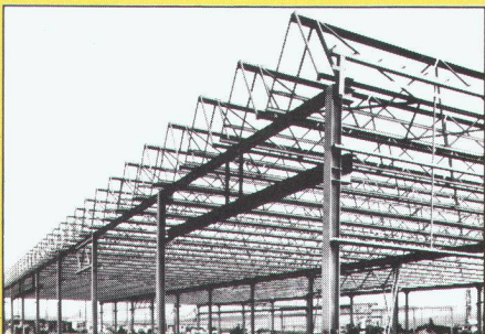
Structure métallique d'une usine – toiture mini-shed –
