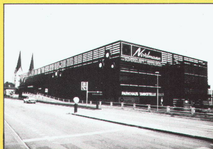
Parking à étages avec accès par rampes
