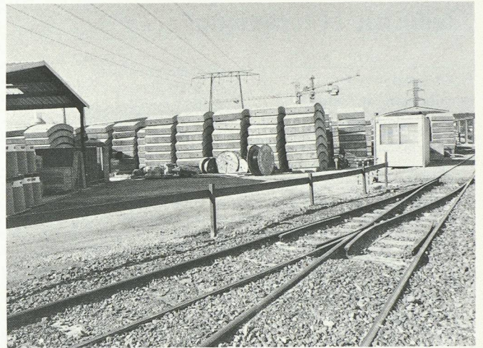
Dépôt de l'usine de préfabrication des voussoirs, à la tête sud du tunnel de Villejust. Le fait que ces éléments ne sont pas identiques exige une identification et une gestion précise de leur manutention.
