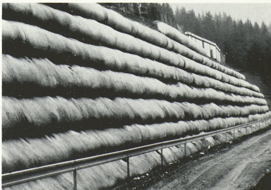
Fig. 2. — Massif en terre renforcée par des géotextiles, hauteur 9,50 m, réalisé à Prapoutel (près de Grenoble, France) en 1982. (Document Enka.)
