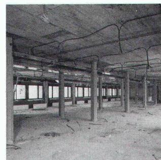
Page de titre représentant les piliers préfabriqués en béton armé centrifugé **GRAM**.
