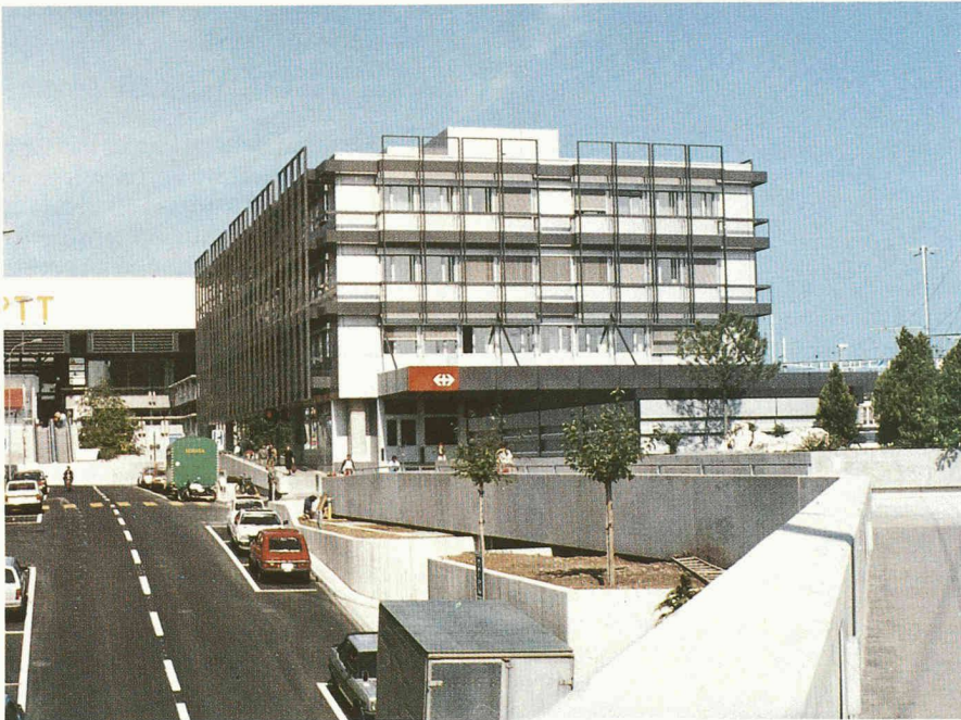
Le bâtiment de service des CFF, vu de la place de Montbrillant. A l'arrière-plan à gauche : le nouveau centre postal.
