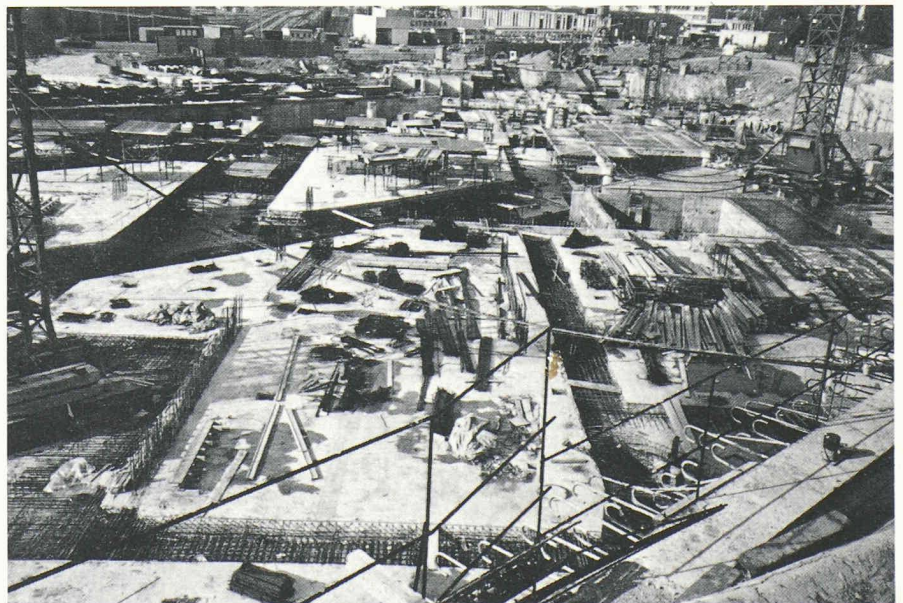
Fig. 9. — Brèches de clavage.
