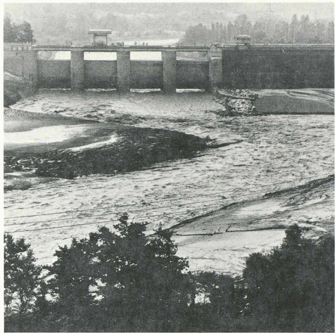
Fig. 7. — Vue d'amont du barrage en chasse (1969) : en rive gauche les restes du dépôt érodé par la déviation des écoulements au moyen du batardeau prolongeant le mur bajoyer centrale-barrage. Upstream view of the dam while flushed: the large sediment deposit on the left bank was partly eroded by the deviated flow as achieved by means of the coffer-dam continuing the plant-dam separation wall.
