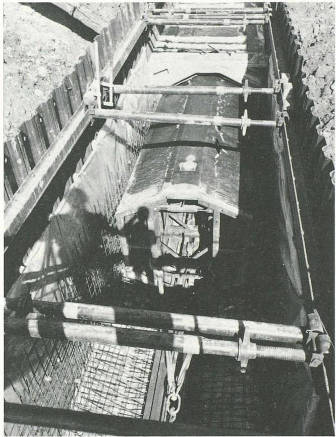
Fig. 2. — Collecteur en cours de bétonnage.
