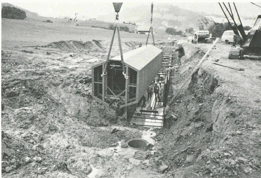
Fig. 4. — Déplacement du coffrage intérieur.
