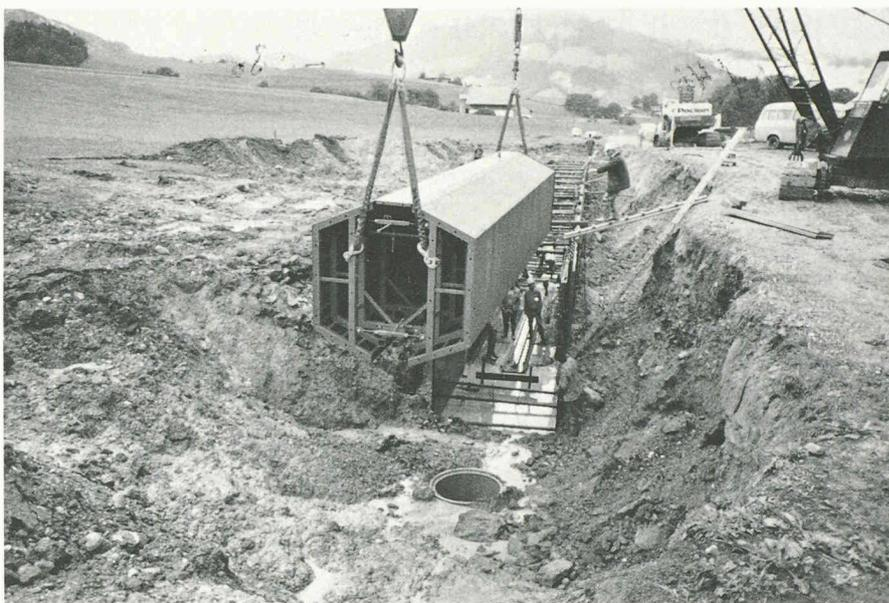
Fig. 4. — Déplacement du coffrage intérieur.
