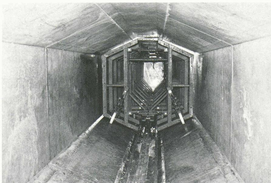
Fig. 5. — Le coffrage à l'extrémité d'une section terminée.
