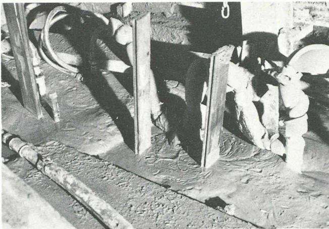
Fig. 5. — Limon fluide en cours de congélation au PK 405. (Photo Fiala.)
