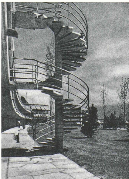
Un des trois escaliers en colimaçon ponctuant la façade de 220 m de long et créant un point d'attraction.
