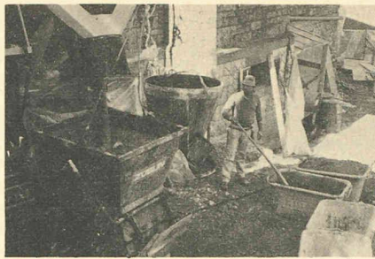
Fig. 5. — Benne de grue, rendue étanche par deux pelletées de sable.
