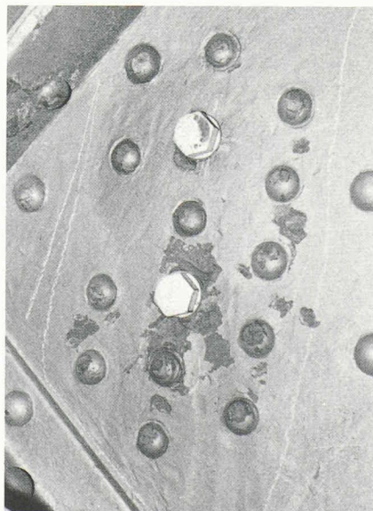
Fig. 12. — Remplacement de rivets par des boulons HR.
