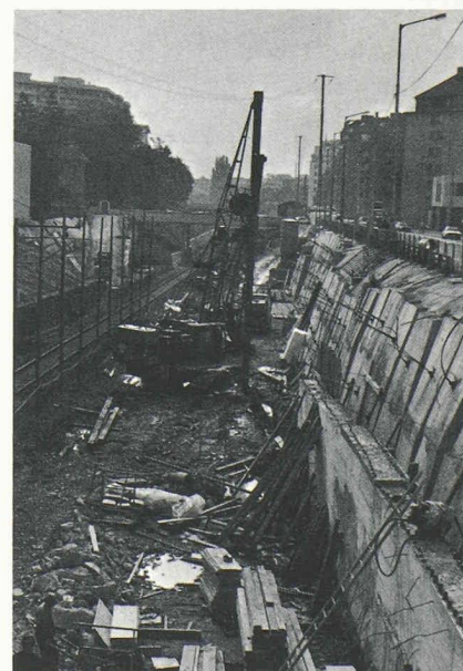
Fig. 12. — Travaux sur le secteur 6 du lot D.
