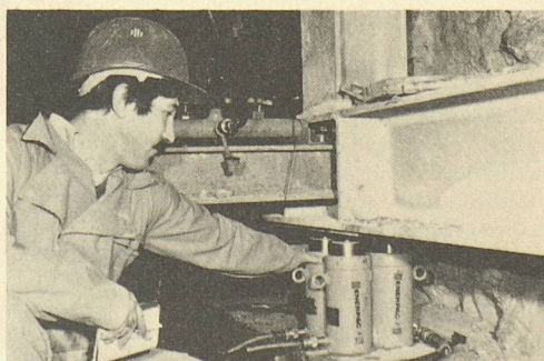
Fig. 2. - Dans la salle des échanges, soutènement de la poutre continue par les poteaux actuels pour la réalisation des structures définitives.
