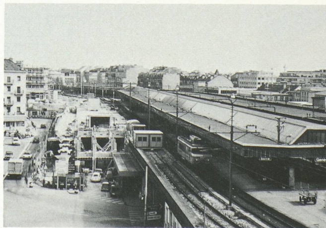
Fig. 8. - Les locaux sous le quai 4 en cours de travaux.
