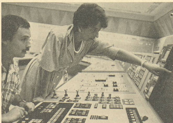
Dans la salle de commande de la centrale nucléaire de Leibstadt: M me Eugénie Zubkovsky indique à l'opérateur les barres de commande qui doivent être déplacées pour atteindre une répartition optimale de la puissance dans le réacteur.
