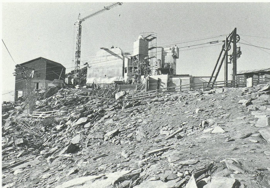
Fig. 1. – Vue générale du chantier; de g. à d.: station du téléphérique, au premier plan le téléphérique de service avec son pylône d'arrivée, au milieu s'élève le bâtiment principal. L'engin de lavage ainsi que la tour à béton ont été acheminés en pièces détachées au moyen du téléphérique de service.
