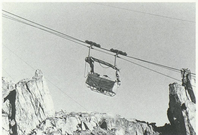
Fig. 6. - Le téléphérique de chantier (charge utile 3,0 t) a été démonté à la fin des travaux.
