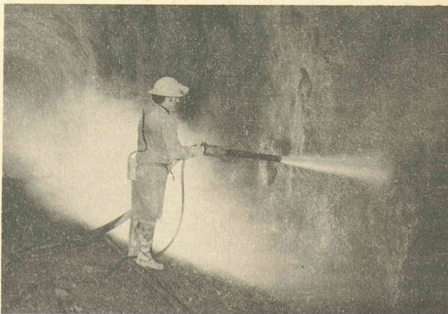
Application de béton projeté dans un tunnel.
