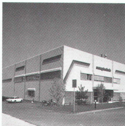
Siège romand de Maag Technic SA, Crissier
