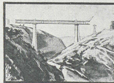
FIG. 3. — CHÂSSIS DE LANÇAGE A BASCULE A 6 PAIRES DE GALETS.
