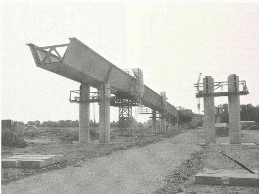
Fig. 4. - Viaduc du Bois-de-Rosset en construction.
