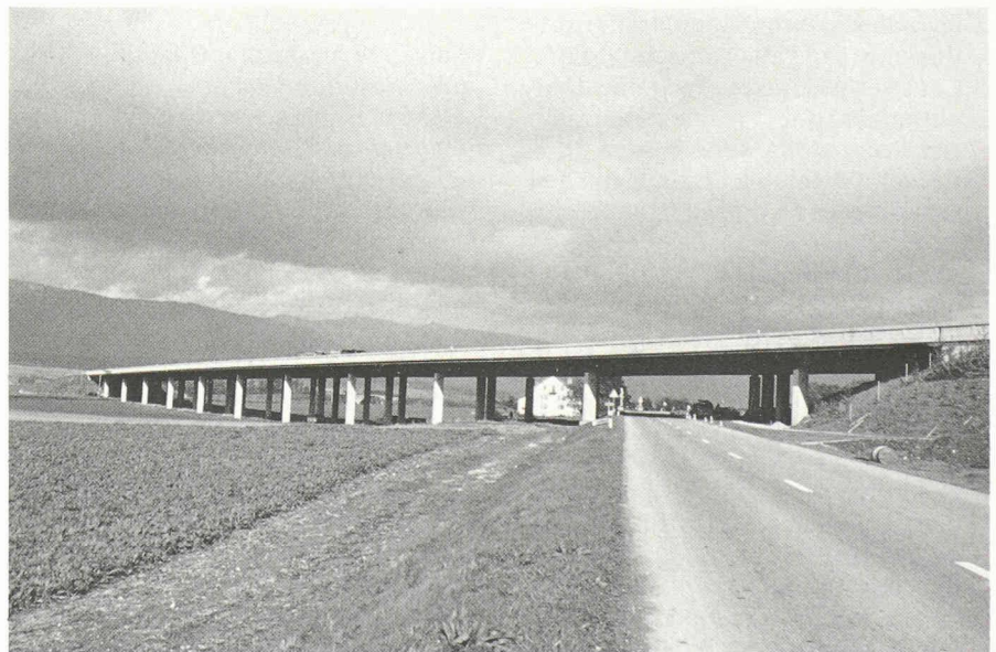
Fig. 2. - Vue des viaducs du Chêne à Chavornay.
