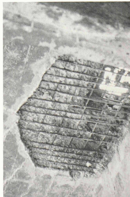
Fig. 9 et 10. – Nid-de-poule découvert un matin dans la dalle de couverture d'un pont en béton armé, près de Reims. C'est seulement ce jour-là qu'on est allé examiner l'ouvrage par en dessous (accès facile sans moyens spéciaux). Bon nombre de panneaux délimités par les poutres principales et les entretoises étaient depuis un certain temps déjà dans un état de dégradation comparable (au trou près) et on ne s'en était jamais aperçu.
