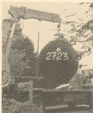
La grue équipant le véhicule de transport soulève la citerne (ici 6000 litres) et la dépose sur l'emplacement sommairement préparé.
