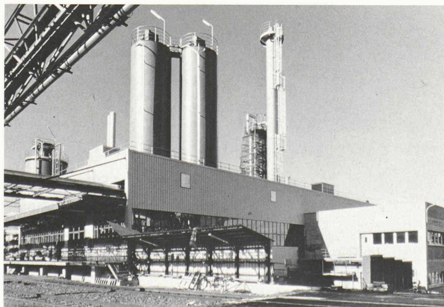
Fig. 3. - Installation d'oxydation par voie humide de l'usine Ciba-Geigy à Monthey. Les deux réacteurs de 40 mètres dominent le bâtiment.
