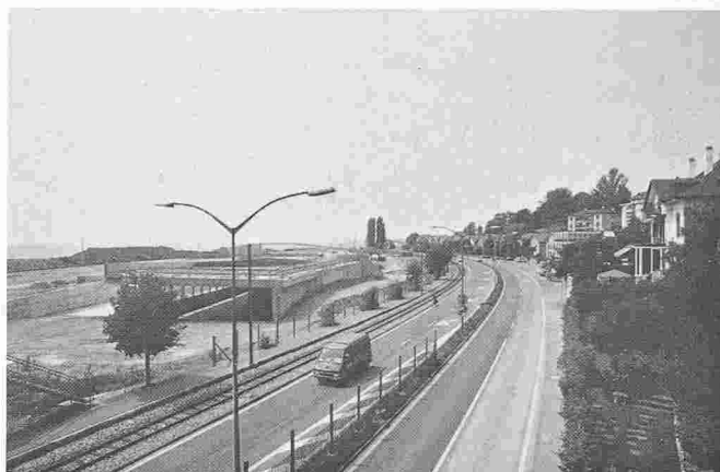
Tunnel ouest. Jonction de Serrières – la partie centrale de la trémie de l'autoroute est construite. On est en train de réaliser la nouvelle voie du Littorail et la future RC5. Dans le courant de cette année, la circulation automobile dans le sens Yverdon–Neuchâtel sera modifiée, empruntant la nouvelle bretelle de la RC5 et imposant un détour par les nouvelles rives. Quant aux usagers du Littorail, ils circulent sur la nouvelle voie depuis fin janvier et s'arrêtent à la nouvelle station.
