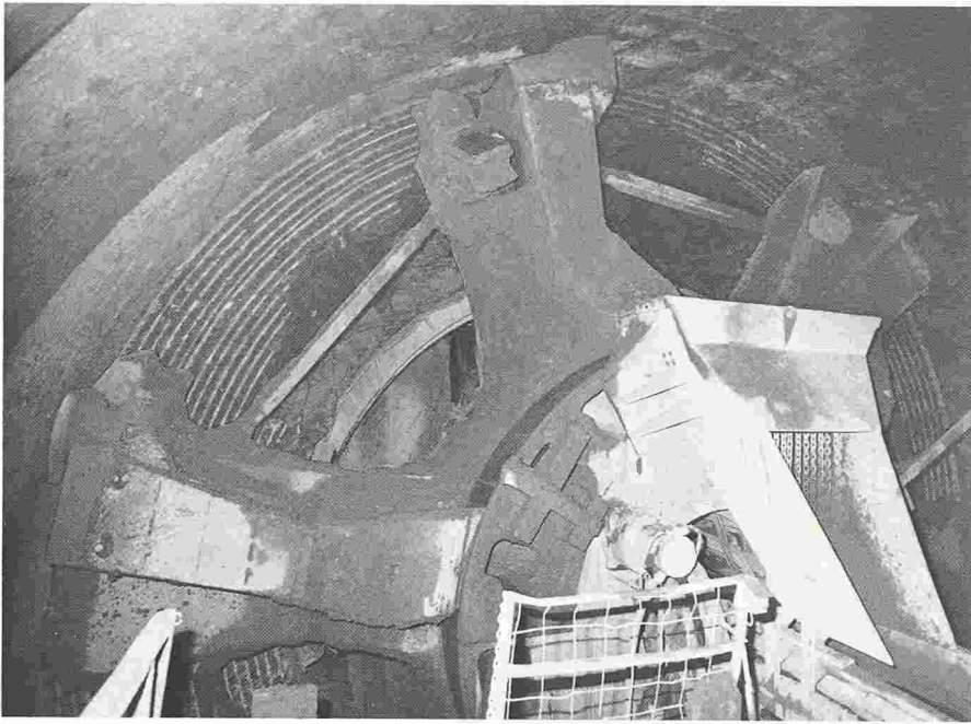
Tunnel est. Vue partielle de la tête rotative d'alésage de \phi 11,0 m du deuxième tunnelier en plein travail (tube nord, 19 septembre 1985).
