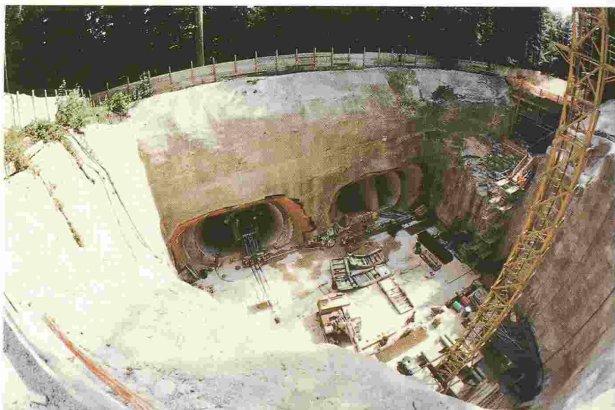
Tunnel est. Fouille de la future centrale de ventilation des Perrolets et les puits de ventilation qui y débouchent. Entièrement souterraine, cette installation forme une sorte de gigantesque aspirateur de 20 m de haut, 31 m de long, 15 m de large en moyenne et qui représente 3000 m 3 de béton et 30 t d'acier d'armature. Ce volume enterré imposant est nécessaire pour abriter les 4 puissants ventilateurs de 5 m de diamètre, pesant 27 t chacun, développant une puissance variant selon les besoins entre 380 et 940 kW et capables d'assurer un débit de 180 à 280 m 3 /s.
