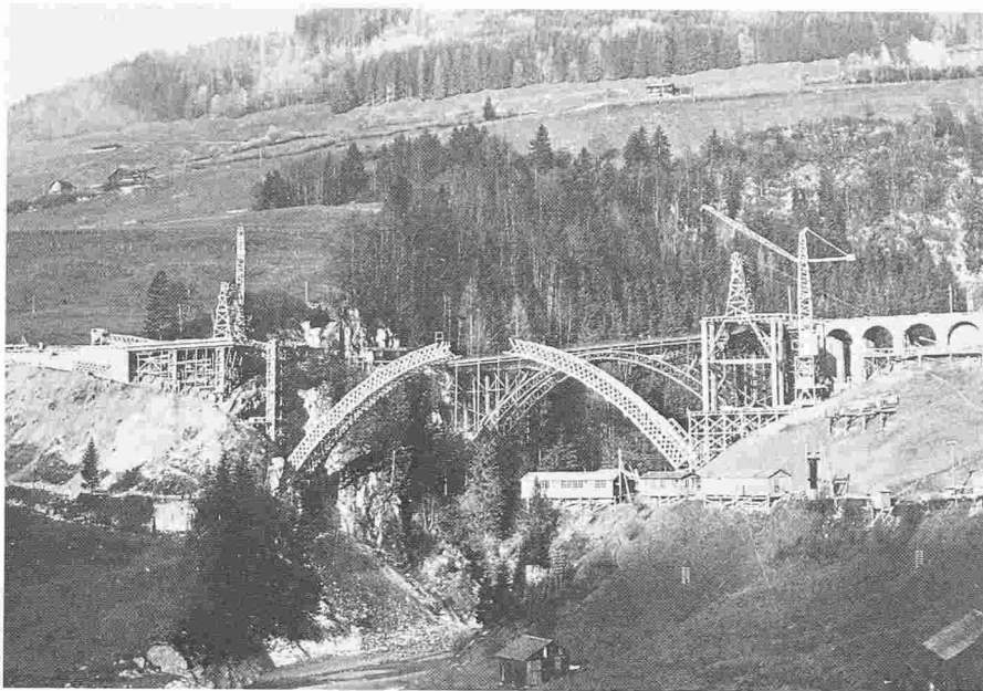
Pont de Javroz sur le col du Jaun, près de Charmey. « Un échafaudage complexe s'imposait pour construire la voûte. »
