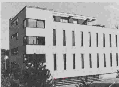
Bâtiment des télécommunications à Unterengstringen
