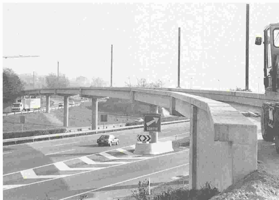
Fig. 7. – Pont de La Bourdonnette: l'ouvrage terminé.
