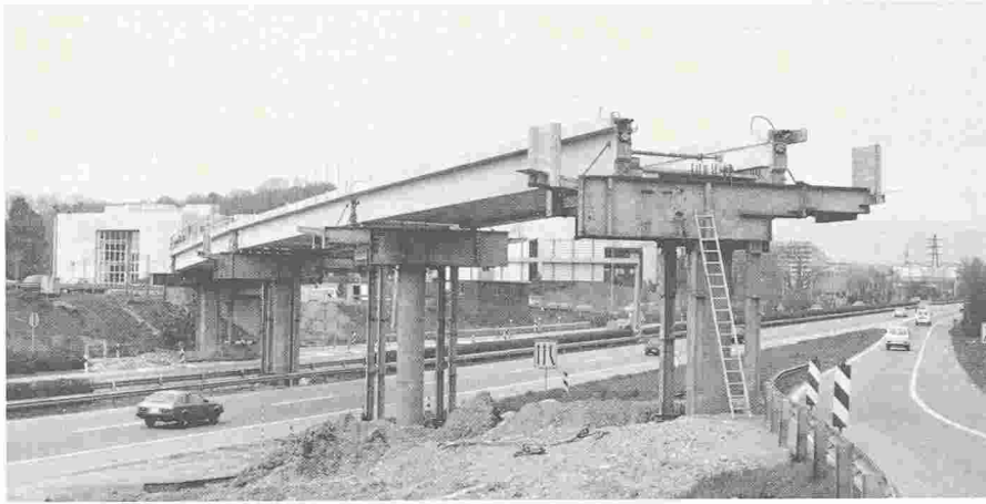
Fig. 6. – Pont de La Bourdonnette. Le trafic sur l'autoroute est maintenu pendant les travaux.
