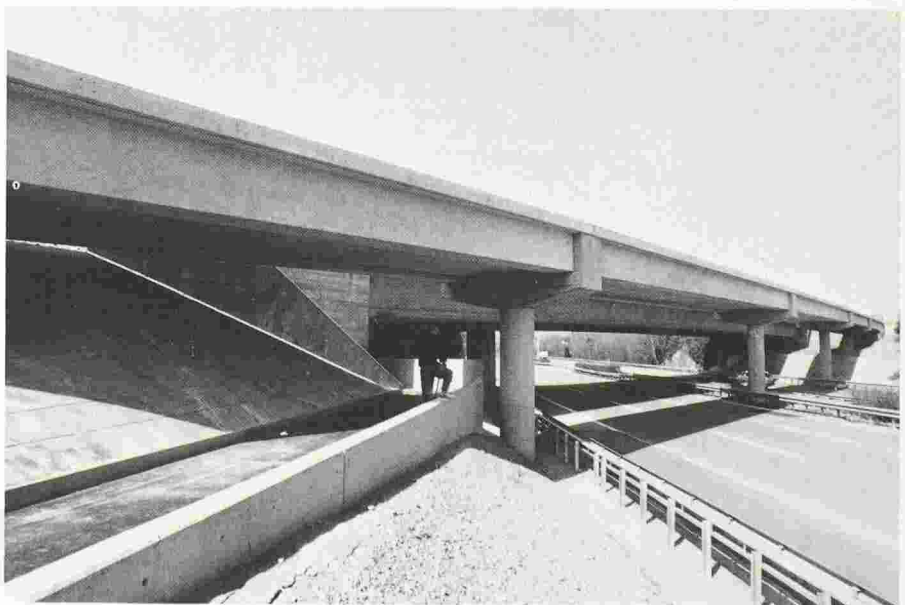
Fig. 9. – Pont du Tir-Fédéral : traversée de l'autoroute en fort biais.
