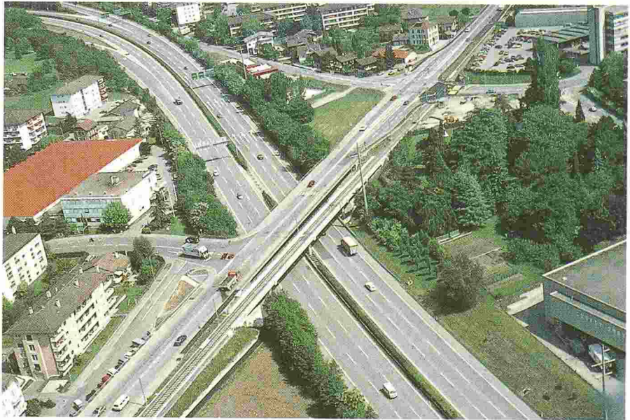
Fig. 11. – Pont du Tir-Fédéral: vue aérienne.
