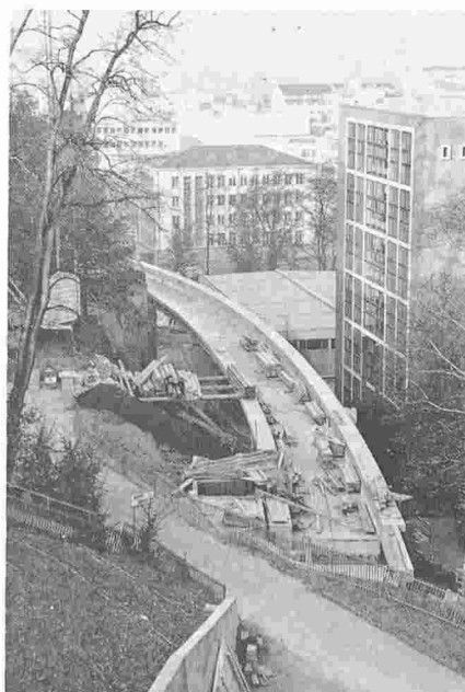
Fig. 5. - Pont de l'EPSIC: tablier terminé.
