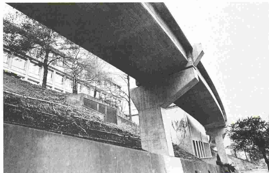
Fig. 8. - Pont de l'EPSIC: pile asymétrique.
