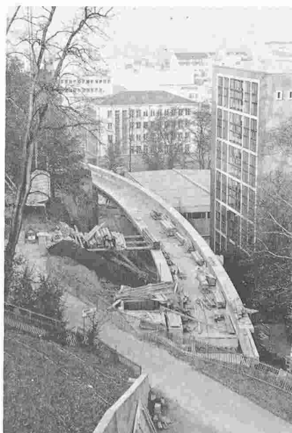
Fig. 5. - Pont de l'EPSIC: tablier terminé.
