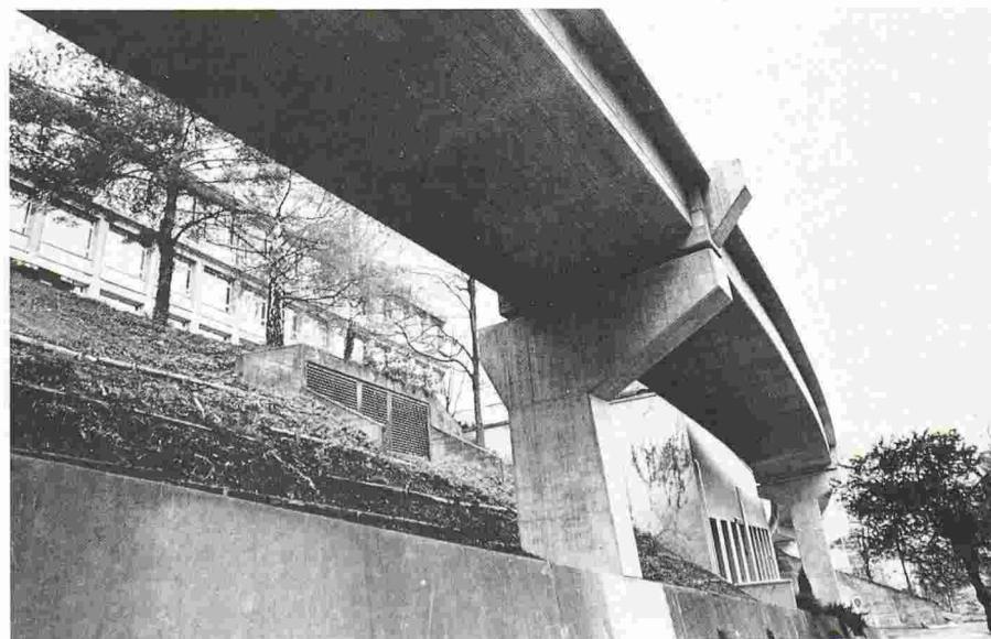
Fig. 8. - Pont de l'EPSIC: pile asymétrique.
