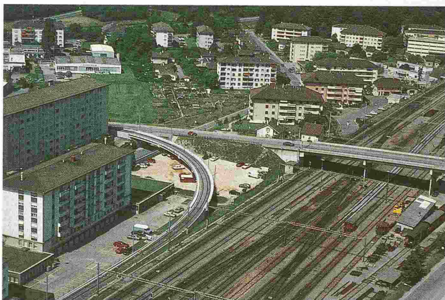
Fig. 26. - Pont d'Epenex: vue aérienne.
