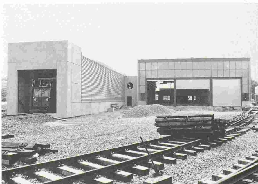
Fig. 4. – Dépôt-atelier: vue depuis l'est.
