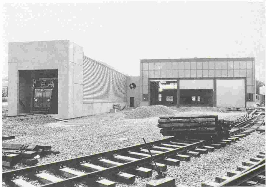
Fig. 4. – Dépôt-atelier: vue depuis l'est.
