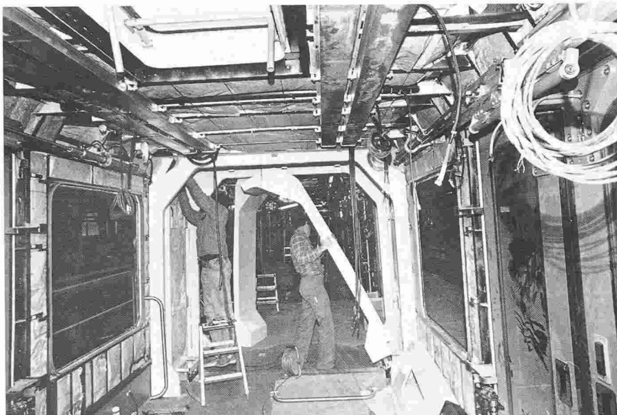
Fig. 4. – Travaux de montage à l'intérieur du caisson.
