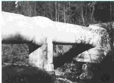
Siphon Rempen, Centrale Hydroélectrique de Wägital AG
