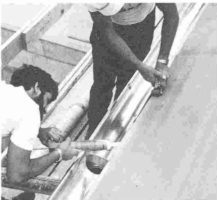
Par soudage ou collage du lé de sous-couverture sur les ferblanteries, les raccords des gouttières sont réalisés sans risque de reflux.
