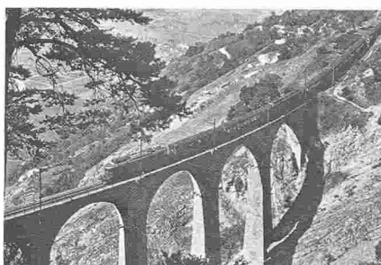
Lötschberg: rampe sud
